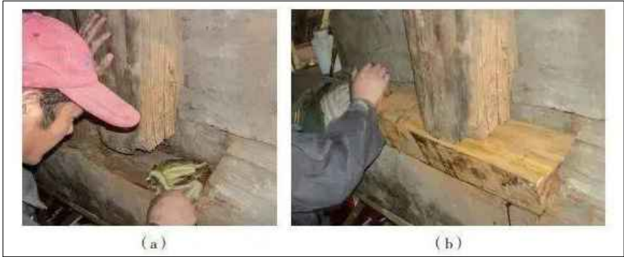
图4.2 糟朽部分剔除、旧料成形成聚氨酯胶粘嵌补
