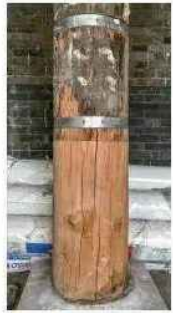
图1.2 墩接横缝示意
