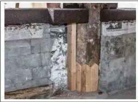
图3.2 包镶(补)后的柱根
